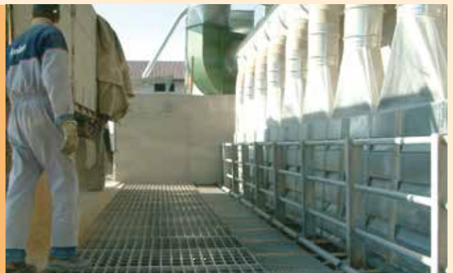
■ Tramoggia di scarico con filtro.
