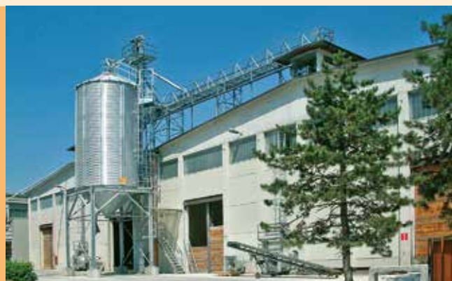
■ Silos carico rapido.
