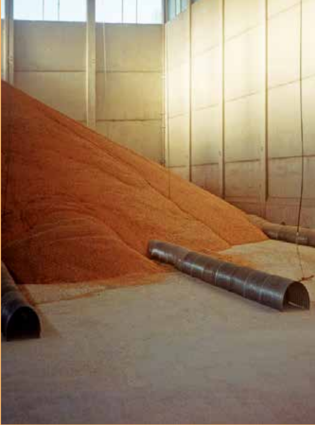
■ Sistema di ventilazione a volta.
