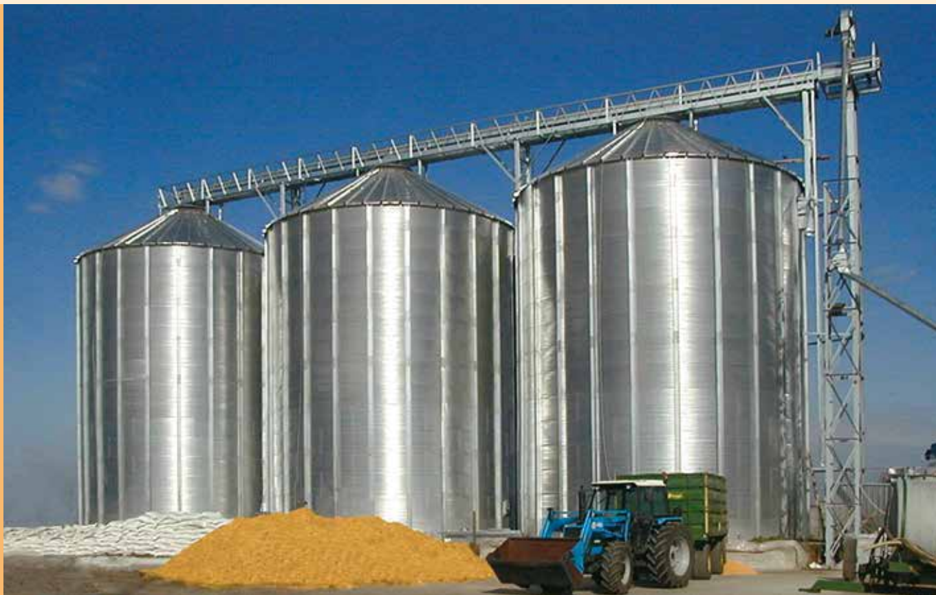
■ Silos di stoccaggio.
